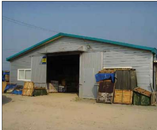
동식물관련시설(이외 축사) - 철골조
