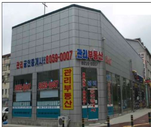
제2종 근린생활시설 - 철골조 중 조립식패널조(메탈판넬)
