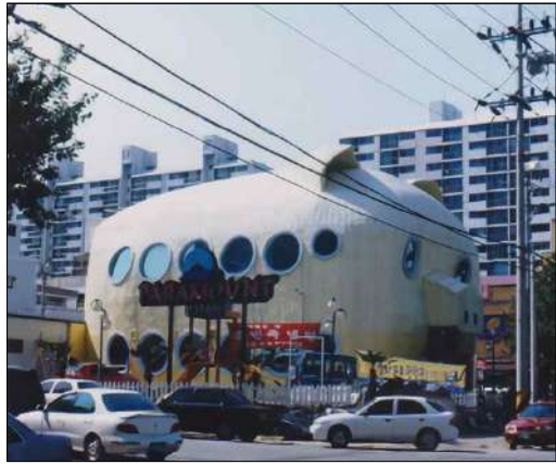
제1종 근린생활시설 - 와이어패널조
