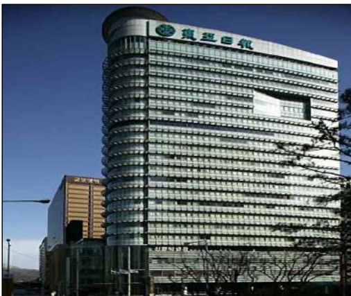
사무소, 신문사 - 철골(철골철근)콘크리트조
