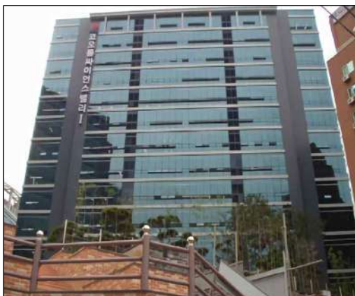
아파트형 공장 - 철근콘크리트조
