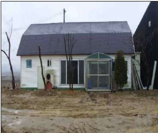
동식물관련시설(이외 축사) - 조립식패널조
