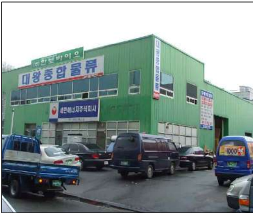
기타판매 및 영업시설 - 철골조
