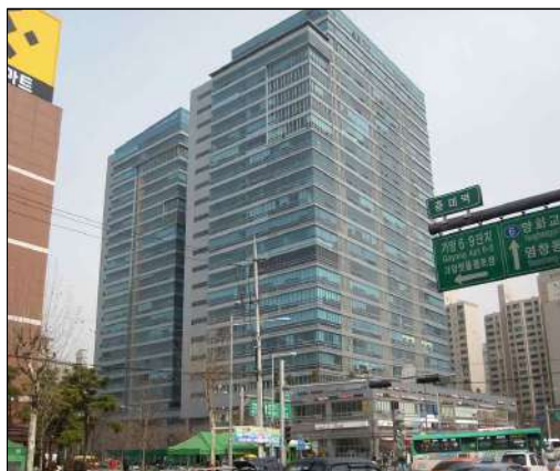
아파트형 공장 - 철골(철골철근)콘크리트조
