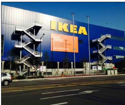
전문점 - 프리캐스트 콘크리트조
