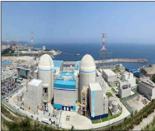
원자력 발전소 - 철근콘크리트조
