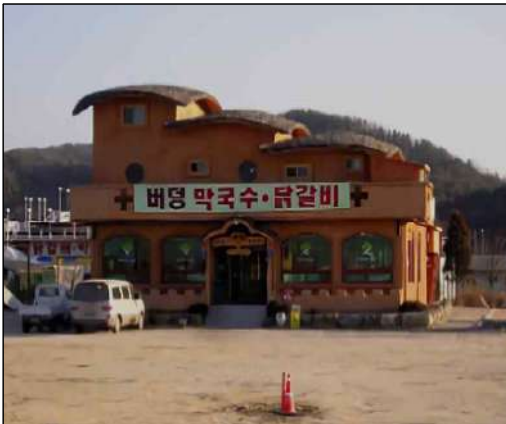
제2종 근린생활시설 - 와이어패널조
