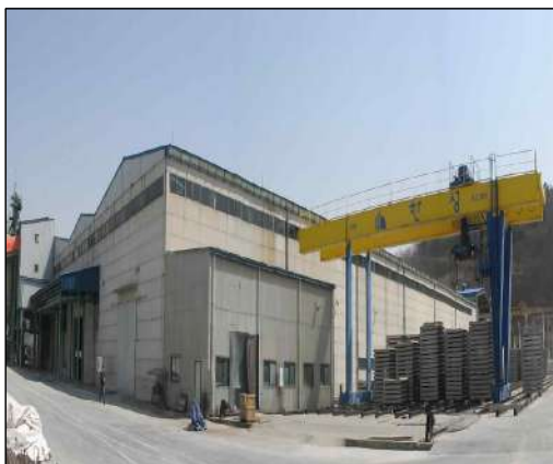
일반공장 - 프리캐스트 콘크리트조
