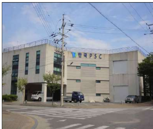
일반공장 - 프리캐스트 콘크리트조
