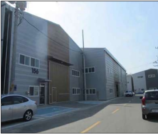
아파트형 공장 - 철골조
