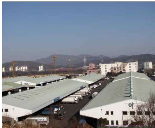
물류터미널 - 조립식 패널조
