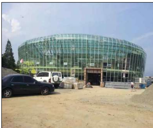
동물원, 식물원 - 철근콘크리트조
