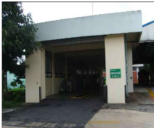
정비공장, 카센터 - 철근콘크리트조
