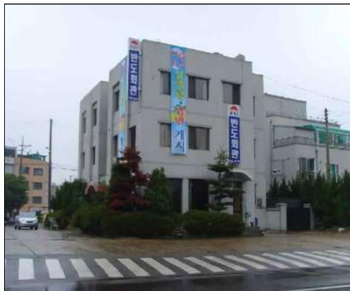
제2종 근린생활시설 - 시멘트블록조
