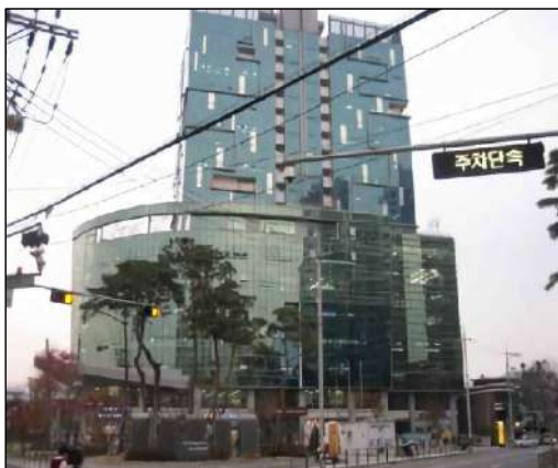
아파트형 공장 - 철골(철골철근)콘크리트조
