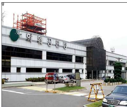
농수축화훼공판장, 경매장 - 철근콘크리트조
