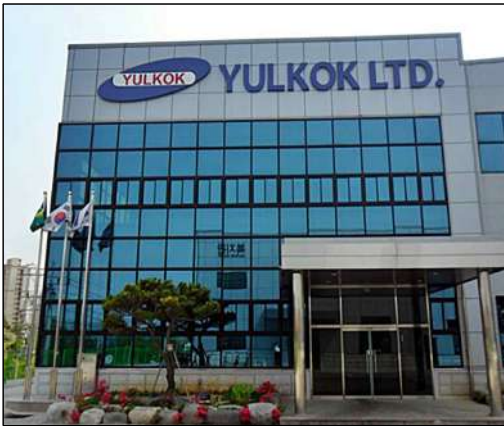
사무소, 신문사 - 철골조 중 조립식패널조(메탈판넬)
