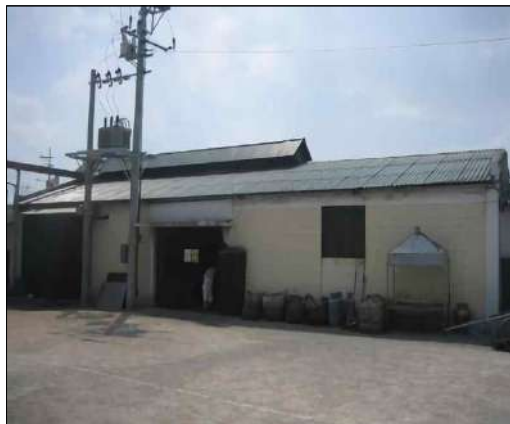
동식물관련시설(이외 축사) - 시멘트블록조
