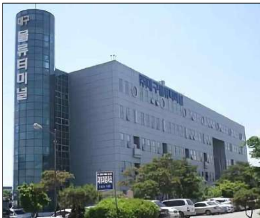
물류 터미널 - 조립식 패널조
