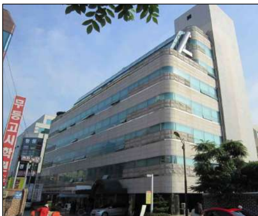
학원 등 - 철골(철골철근)콘크리트조
