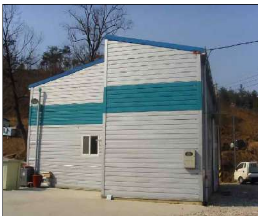
제1종 근린생활시설 - 철골조 중 조립식패널조
