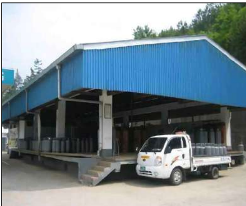
주유소, 충전소, 저장소 - 경량철골조
